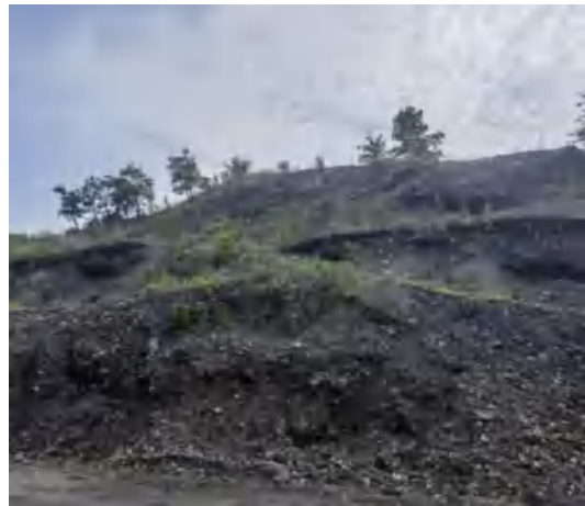
项目西侧现状矸石堆场
