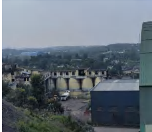
项目北侧大庄矿铁路货运站
