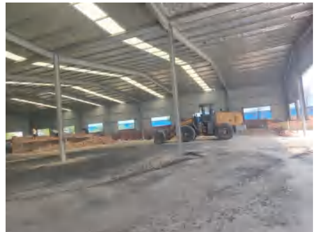
新建配煤系统现状
