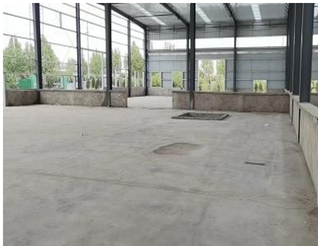
项目厂房内现状
